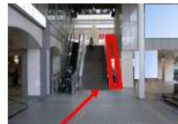
▲下りエスカレーター新設工事
